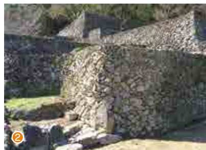
修復された石垣
