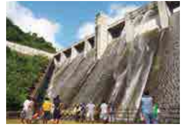
迫力満点の洗浄放水（12：00、13：00、14：00）は必見です
