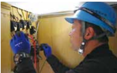
家庭内の配電盤の確認作業を行う南宇和電気工事組合の岩村真典理事長
