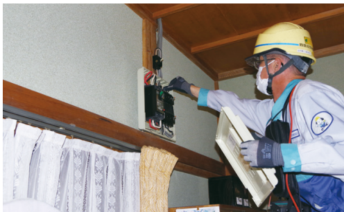
家庭内の配電盤の確認作業を行う四国電気保安協会の山下耕二さん
