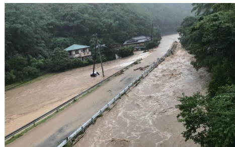
平成30年7月豪雨災害（満倉地区）
