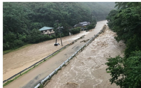
平成30年7月豪雨災害（満倉地区）
