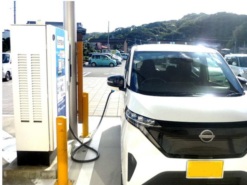
急速充電中の電気自動車
