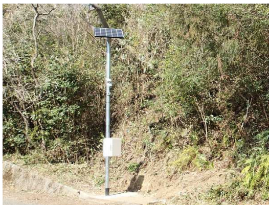
監視カメラの設置
