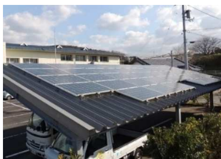
太陽光発電システムの設置
