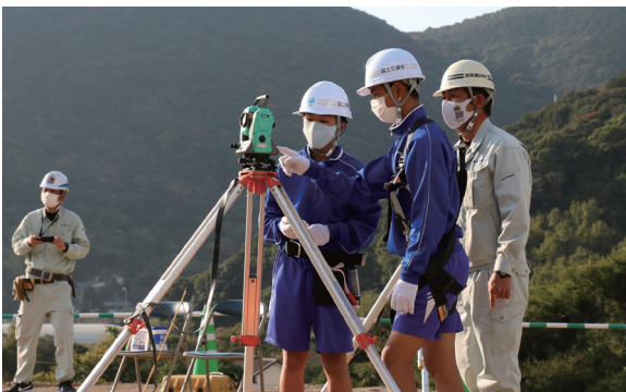
▲工事施工業者の方に手ほどきを受け、測量体験を行う生徒たち
